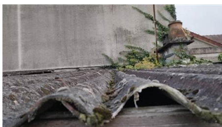
Matériaux : ZPSO-027 Prélèvement : P027 Description : Plaques en fibres-ciment (y compris plaques « sous tuiles ») Localisation : 1er étage - toiture dessus ch 2 et 3 Résultat : Présence d'amiante
