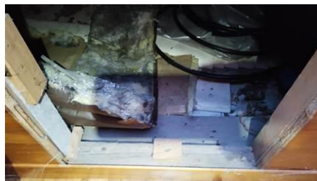
Matériaux : ZPSO-032 Prélèvement : P032 Description : Ragréage Localisation : 1er étage - chaufferie Résultat : Absence d'amiante
