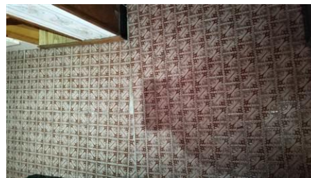
Matériaux : ZPSO-003 Prélèvement : P003 Description : Colle de carrelage Localisation : Rez de chaussée - entrée Résultat : Absence d'amiante
