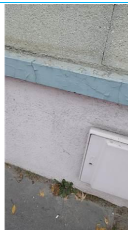
Matériaux : ZPSO-034 Prélèvement : P034 Description : Appui de fenêtres en fibres-ciment Localisation : Rez de chaussée - façade Résultat : Absence d'amiante
