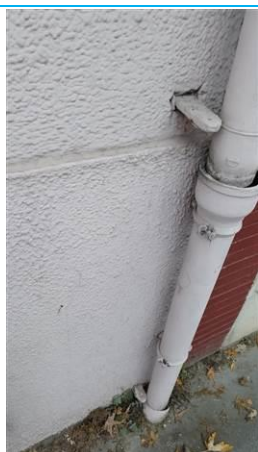
Matériaux : ZPSO-035 Prélèvement : P035 Description : Crépis extérieur Localisation : Rez de chaussée - façade Résultat : Absence d'amiante
