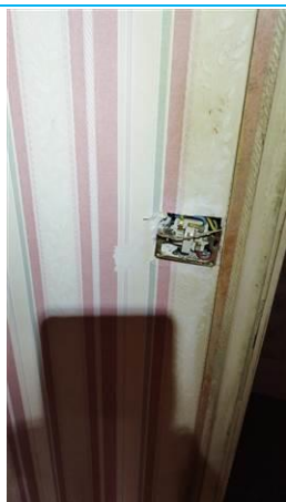
Matériaux : ZPSO-004 Prélèvement : P004 Description : Enduits à base de plâtre ou ciment projetés, lissés ou talochés Localisation : Rez de chaussée - chambre 1 Résultat : Absence d'amiante
