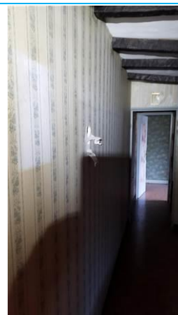
Matériaux : ZPSO-028 Prélèvement : P028 Description : Bandes calicot Localisation : 1er étage - chambre 5 Résultat : Absence d'amiante
