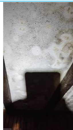
Matériaux : ZPSO-026 Prélèvement : P026 Description : Enduit à base de plâtre projeté Localisation : Rez de chaussée - cuisine 1 Résultat : Absence d'amiante
