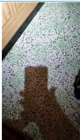
Matériaux : ZPSO-002 Prélèvement : P002 Description : Colle de carrelage Localisation : Rez de chaussée - véranda Résultat : Absence d'amiante
