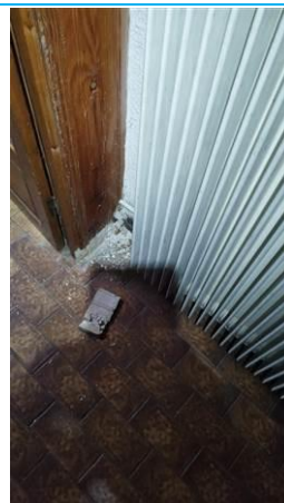
Matériaux : ZPSO-020 Prélèvement : P020 Description : Colle de plinthe Localisation : Rez de chaussée - cuisine 1 Résultat : Absence d'amiante
