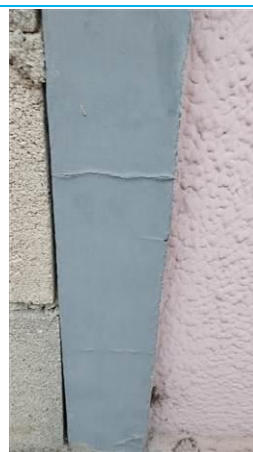
Matériaux : ZPSO-036 Prélèvement : P036 Description : ebrasements Localisation : Rez de chaussée - façade Résultat : Absence d'amiante
