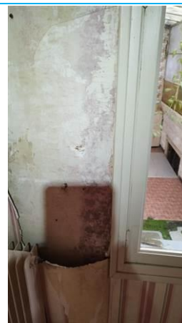
Matériaux : ZPSO-005 Prélèvement : P005 Description : Enduits à base de plâtre ou ciment projetés, lissés ou talochés mur périphérique Localisation : Rez de chaussée - chambre 1 Résultat : Absence d'amiante
